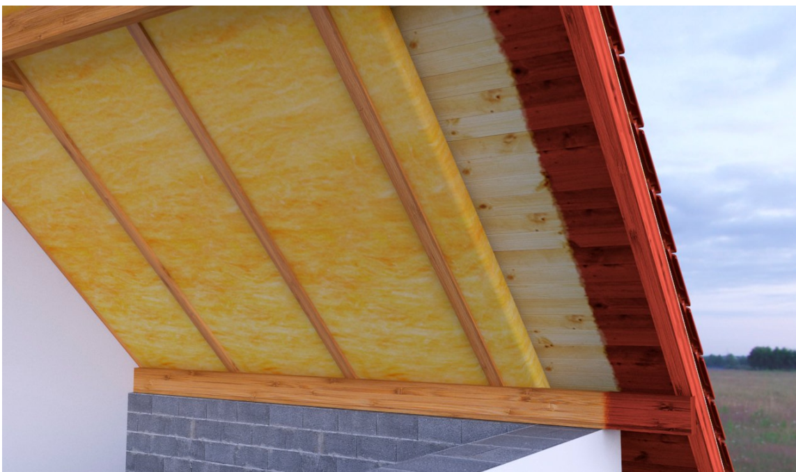
Slika 2. Prikaz nakon postavljene termo izolacije.
