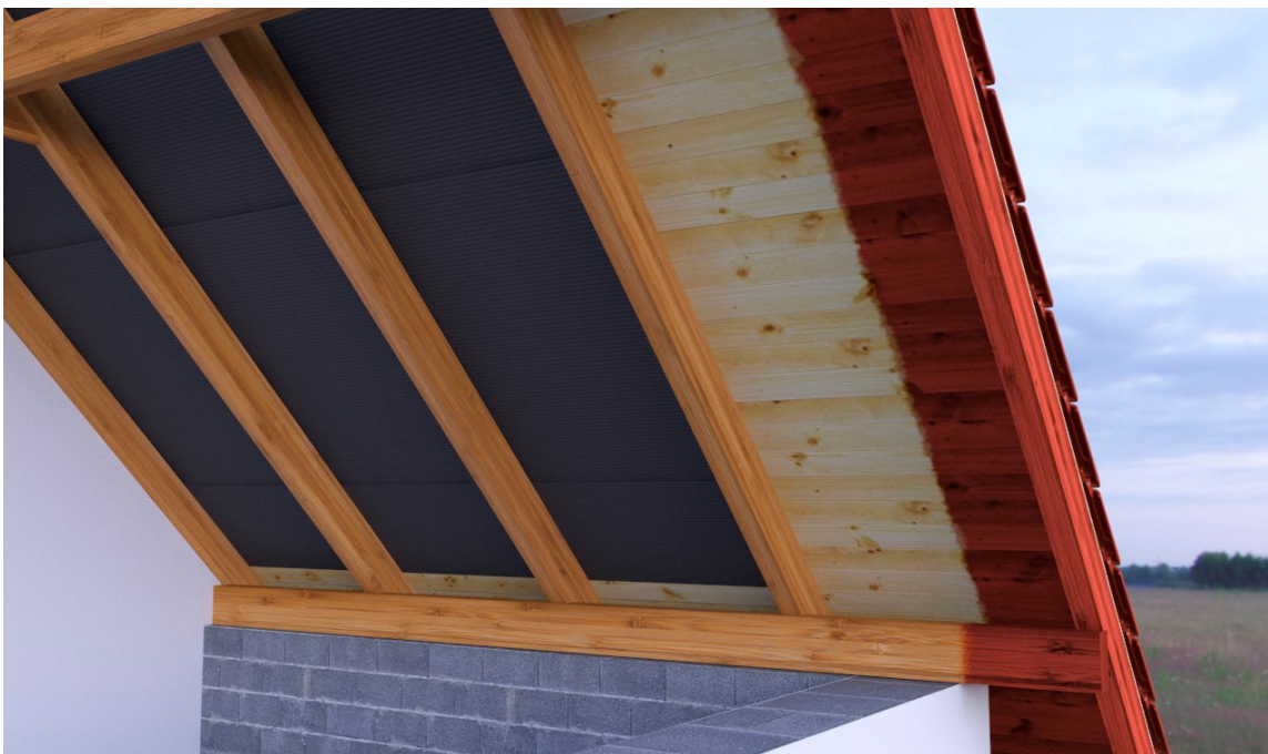
Slika 1. Prikaz potkrovlja ne daskanog krova. Krovna folija aplicirana je direktno na grede
