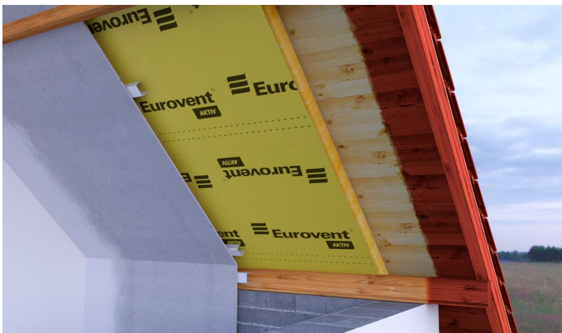
Slika 4. Prikaz postavljanja suhog profila - zatvaranje potkrovne konstrukcije.
